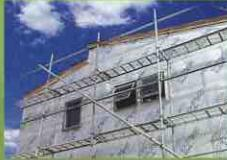
赤外線の反射率が高い遮熱シートも建物の味方。夏は外の赤外線を跳ね返して室内を涼しく、冬は室内暖房の赤外線を放出せず暖かさを持続するデュポン®タイベック®シルバー／デュポン
