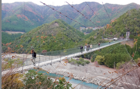
谷瀬(たにぜ)の吊橋:世界一長い生活用鉄線吊橋(*)
